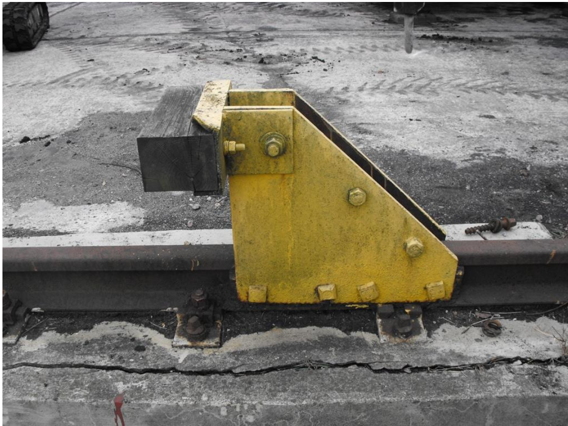
Odbój – łączenie do szyny
