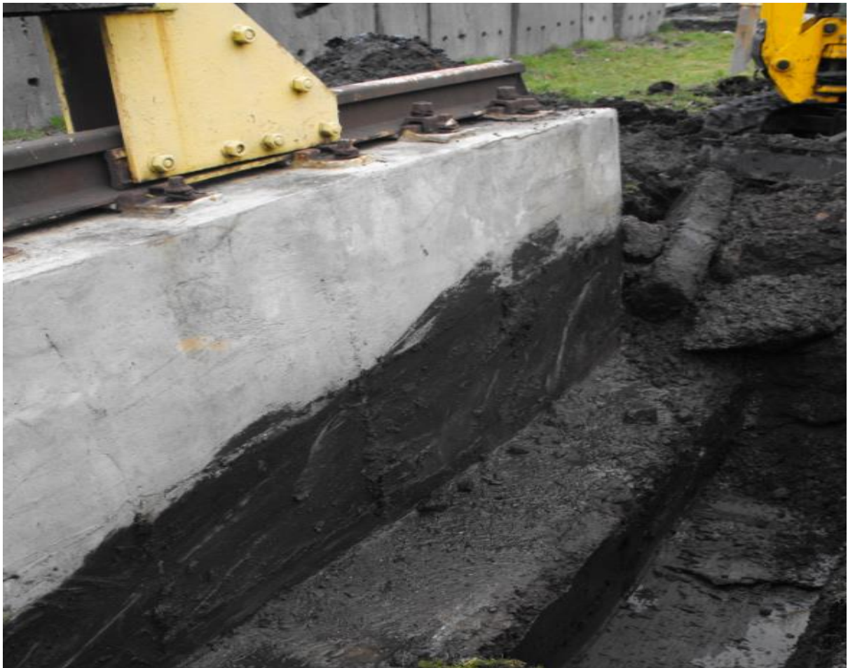
Odkrywka ławy - oś B - bez ingerencji w ławę fundamentową
