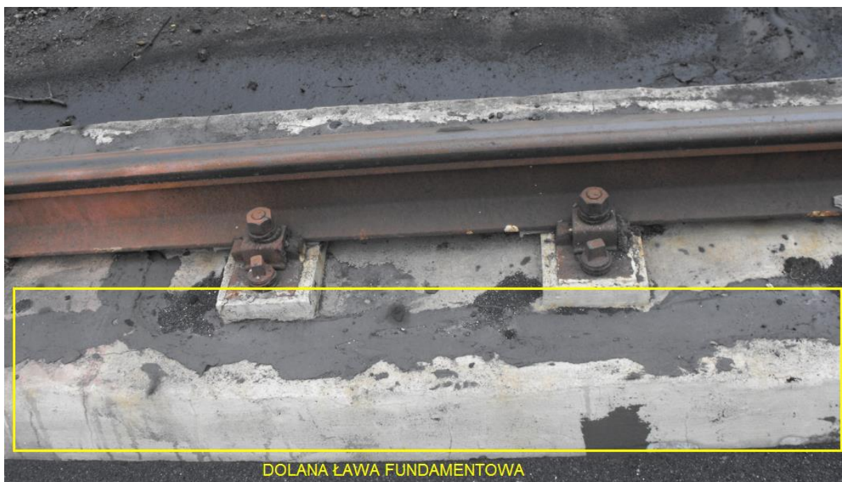
Nadlana ława fundamentu – odsunięta łopata
