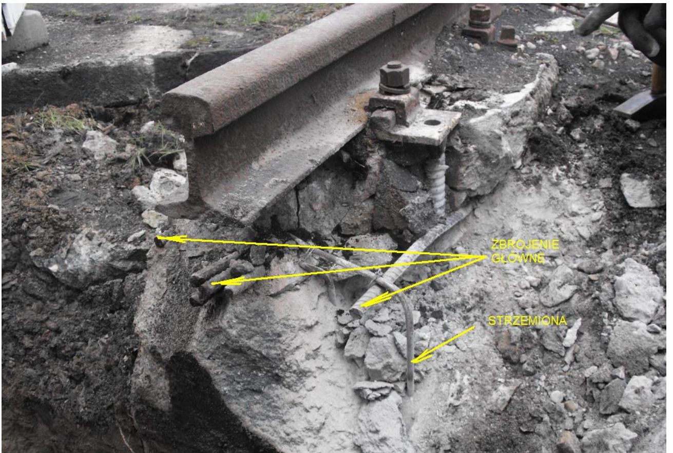
Odkrywka ławy - oś A - z ingerencji w ławę fundamentową
