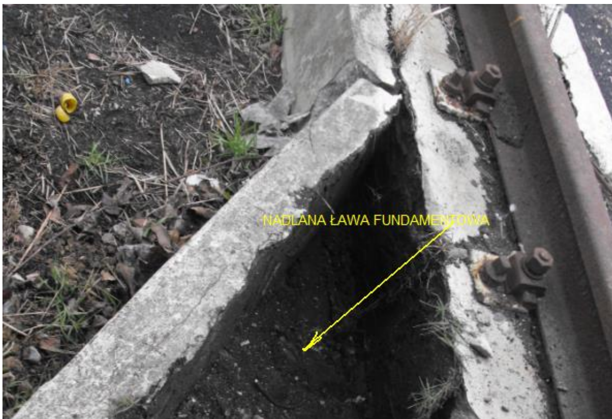
Nadlana ława fundamentu – odsunięta łopata
