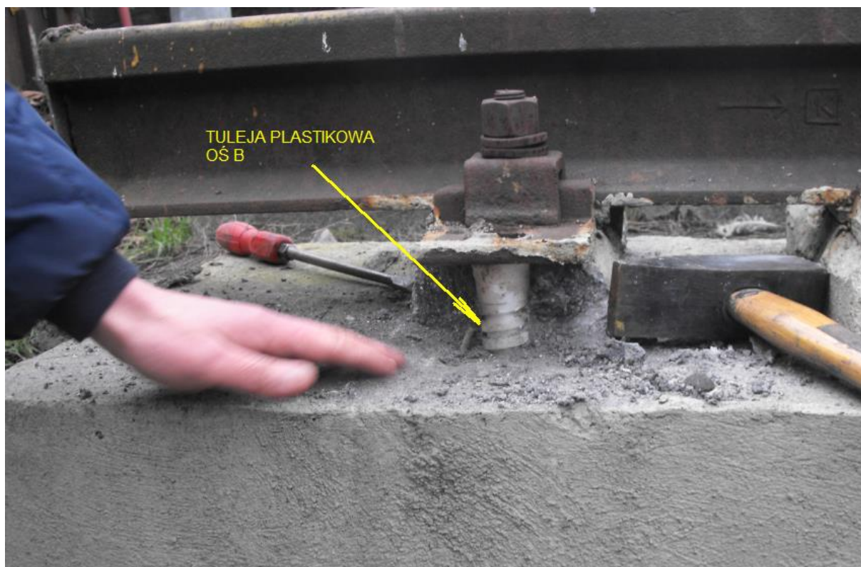
Tuleja plastikowa w osi B w znacznej części wystaje poza ławę fundamentową. Podlewa z masy niskoskurczowej w osi B w granicy 6-10cm
